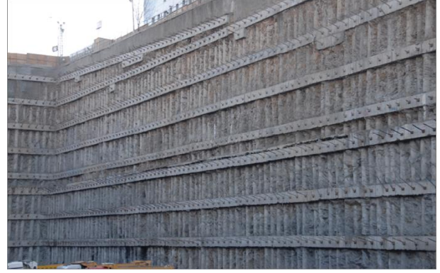
Şekil 2. Derin Kazılarda İksa Sistemi Uygulaması
