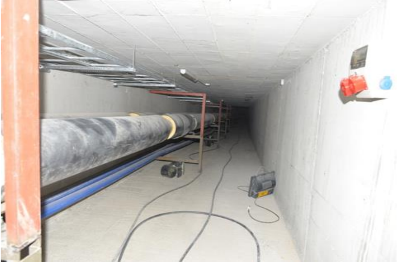
Resim 9: İkinci Etap Galeri Hattı Yapım İşi-I
