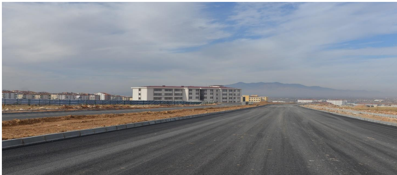
Resim 11: İkinci Etap Yol Yapım İşİ
