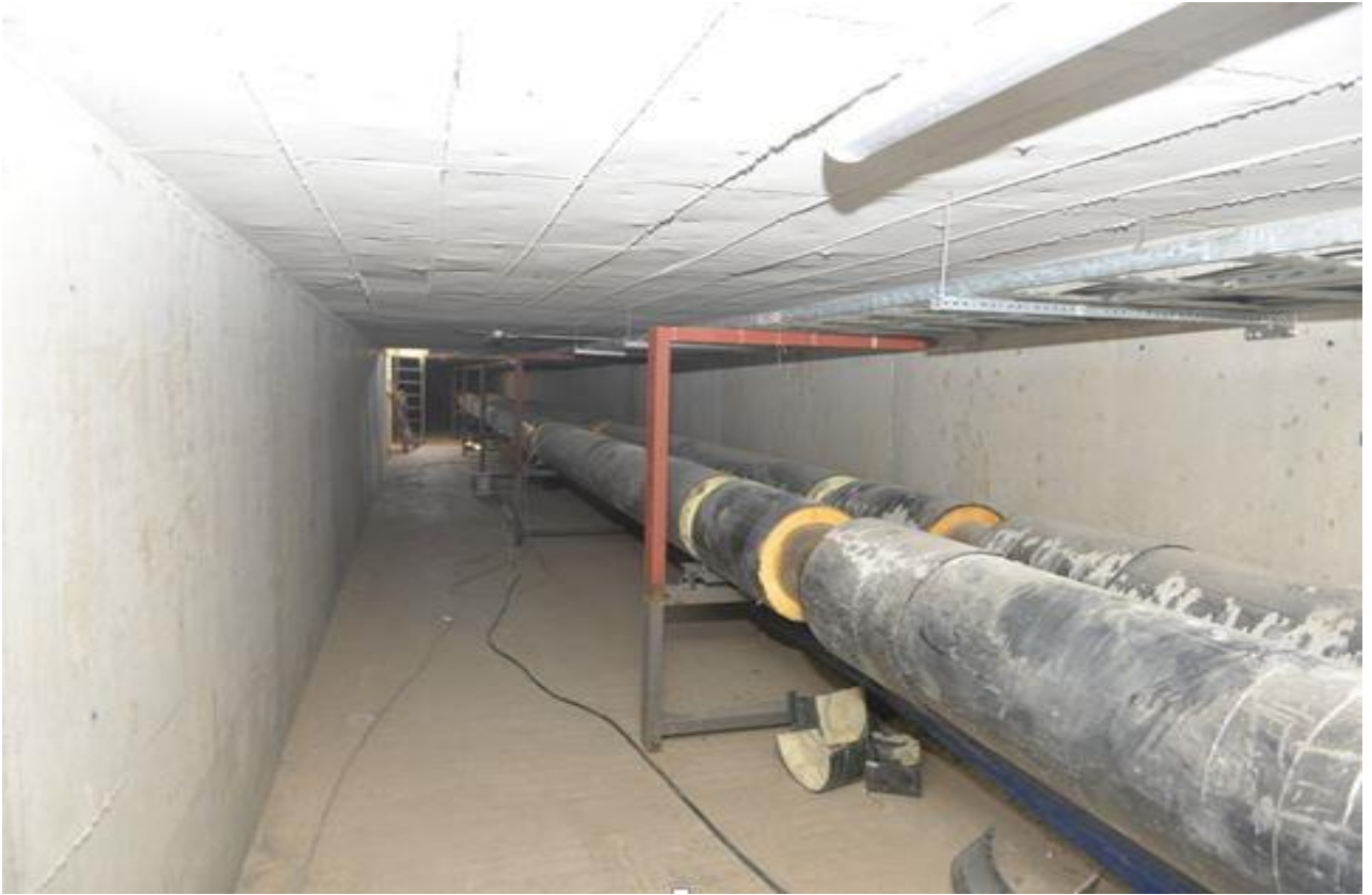
Resim 10: İkinci Etap Galeri Hattı Yapım İşi-II
