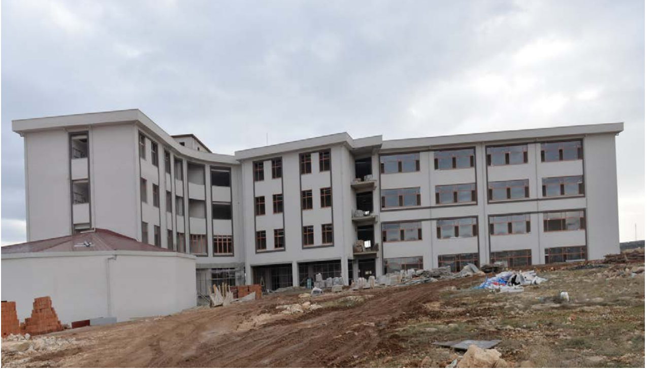
Resim 11: Sağlık Bilimleri Fakültesi bina inşaatı
