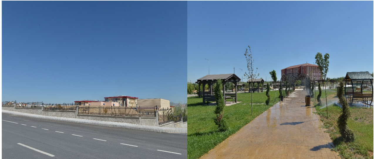
Resim 2: Kampüs Altyapısı Projesi Kapsamındaki Yapım İşleri
