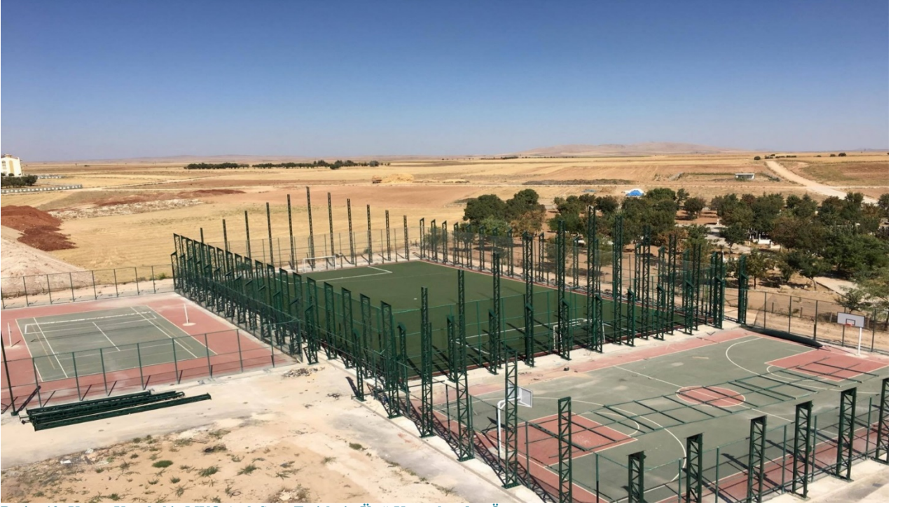
Resim 12: Kazım Karabekir MYO Açık Spor Tesisleri - Üstü Kapatılmadan Önce
