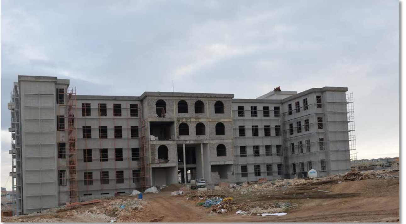
Resim 9: Eğitim Fakültesi Binası İnşaatı
