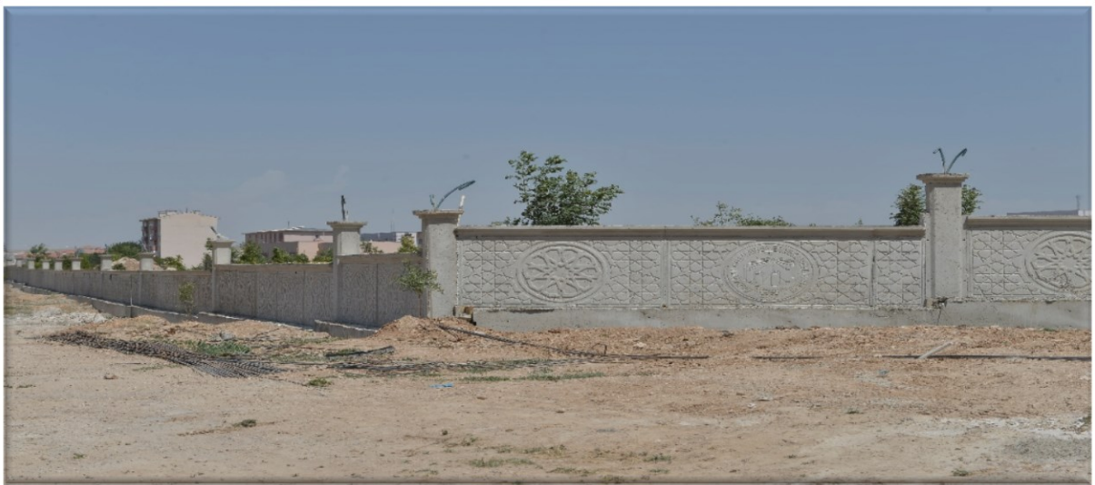
Şekil 16: İhata Duvarı Yapım İşi
