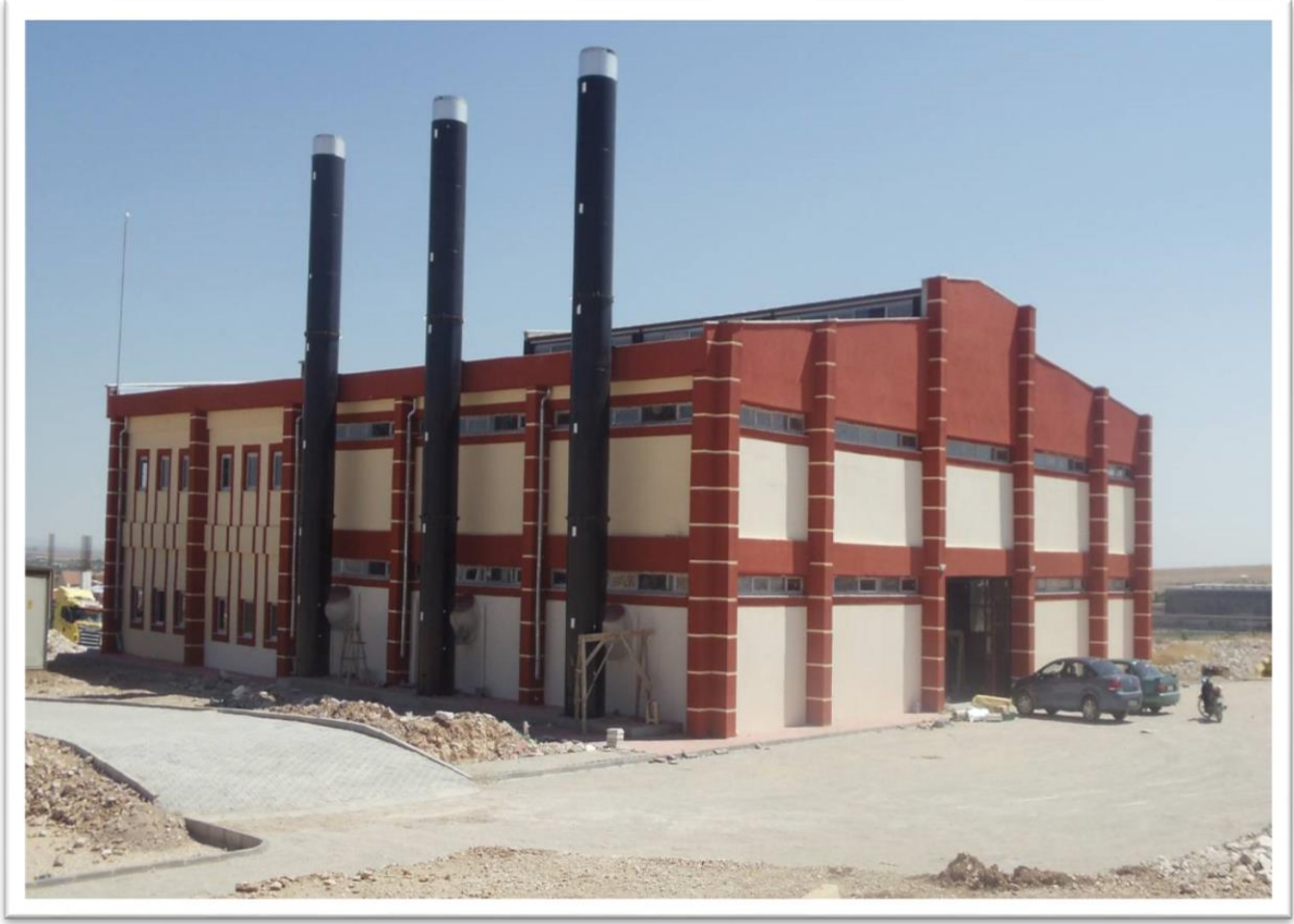
Şekil 8: Isı Merkezi Dış Görünüm
