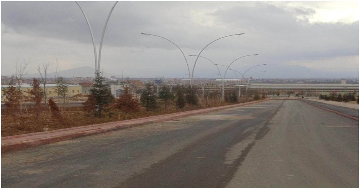
Yunus Emre Yerleşkesi Asfalt Yol ve Çevre Düzenlemesi
