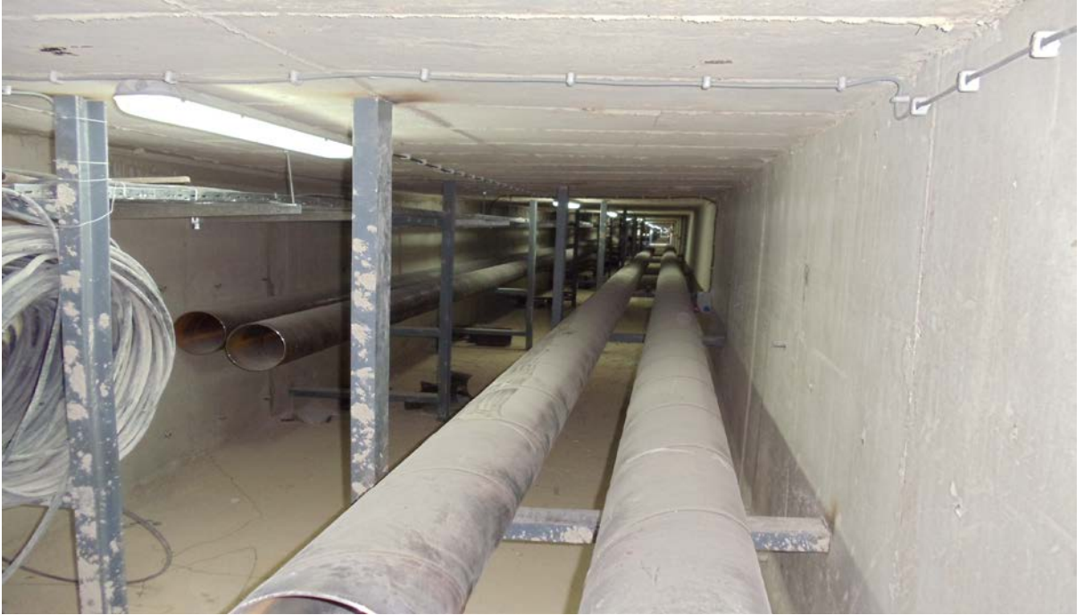
1. Etap Alt Yapı, Galeri ve Isı Merkezi Yapımı İşi
