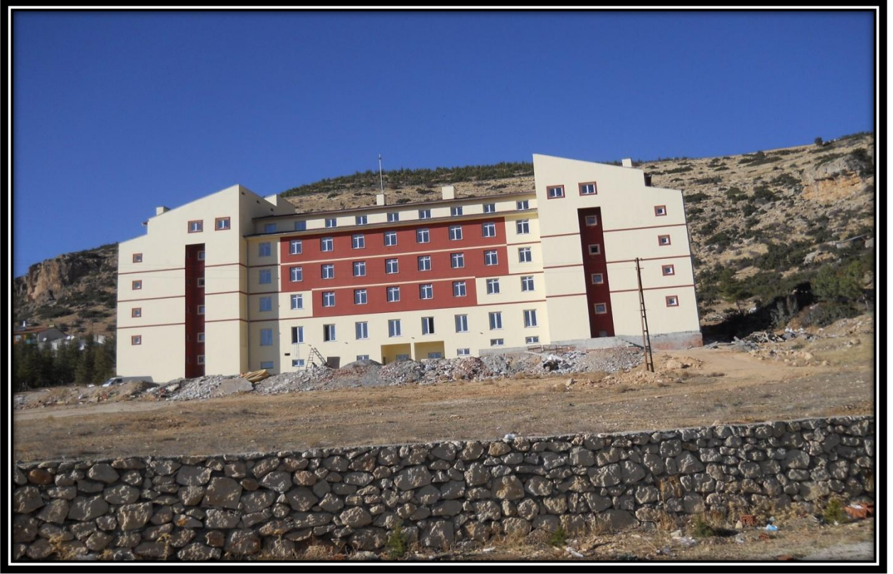
Ermenek 300 Yataklı Yurt Binası İnşaatı Görünümü
