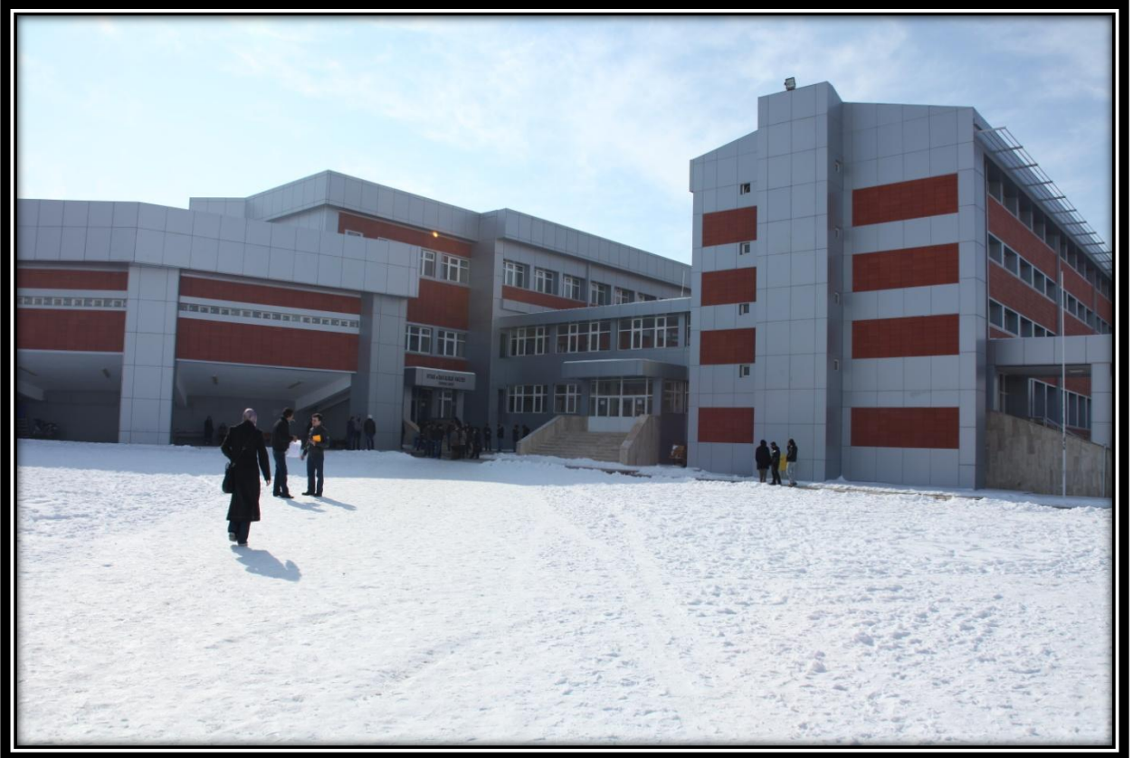
İktisadi ve İdari Bilimler Fakültesi Derslik Amfi İkmal ve Yapım İşine ait görünüm
