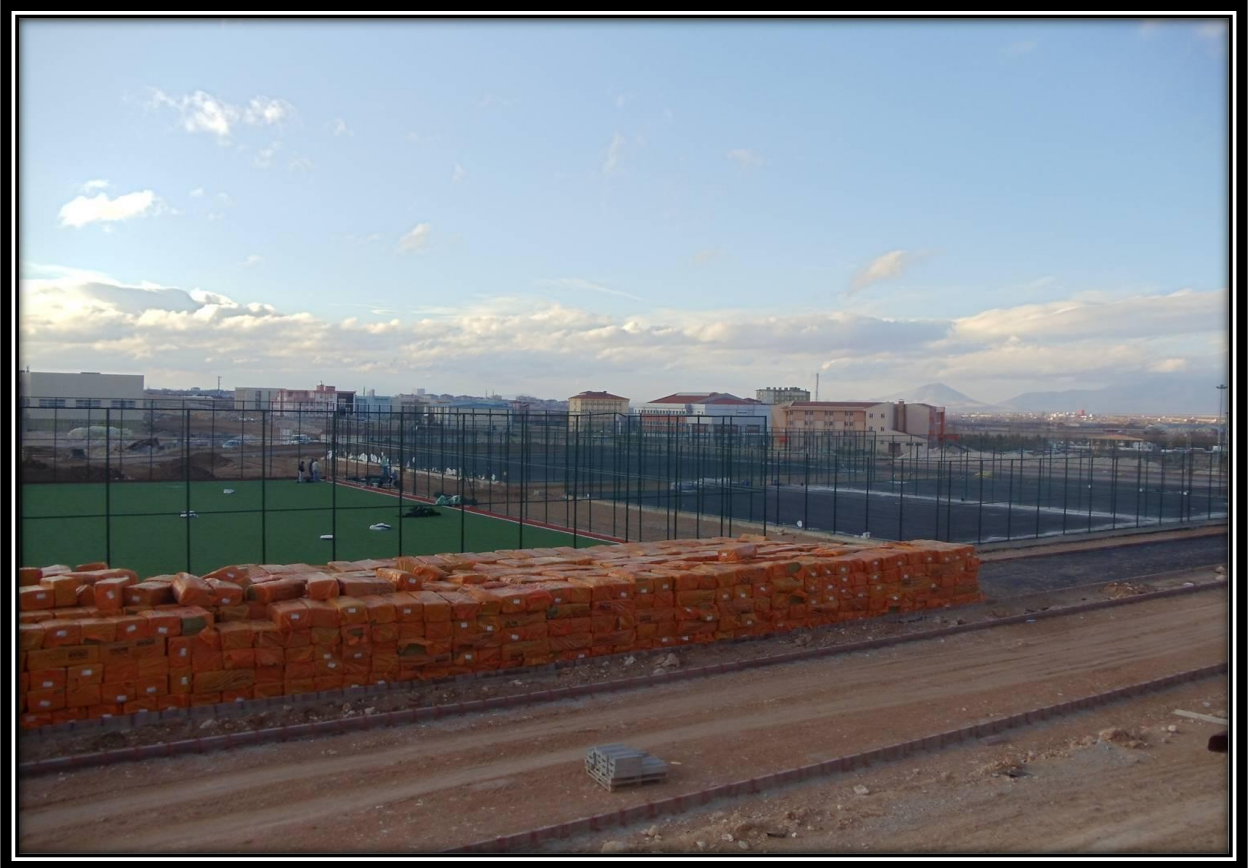
Açık Spor Tesisleri İnşaatından Görünüm
