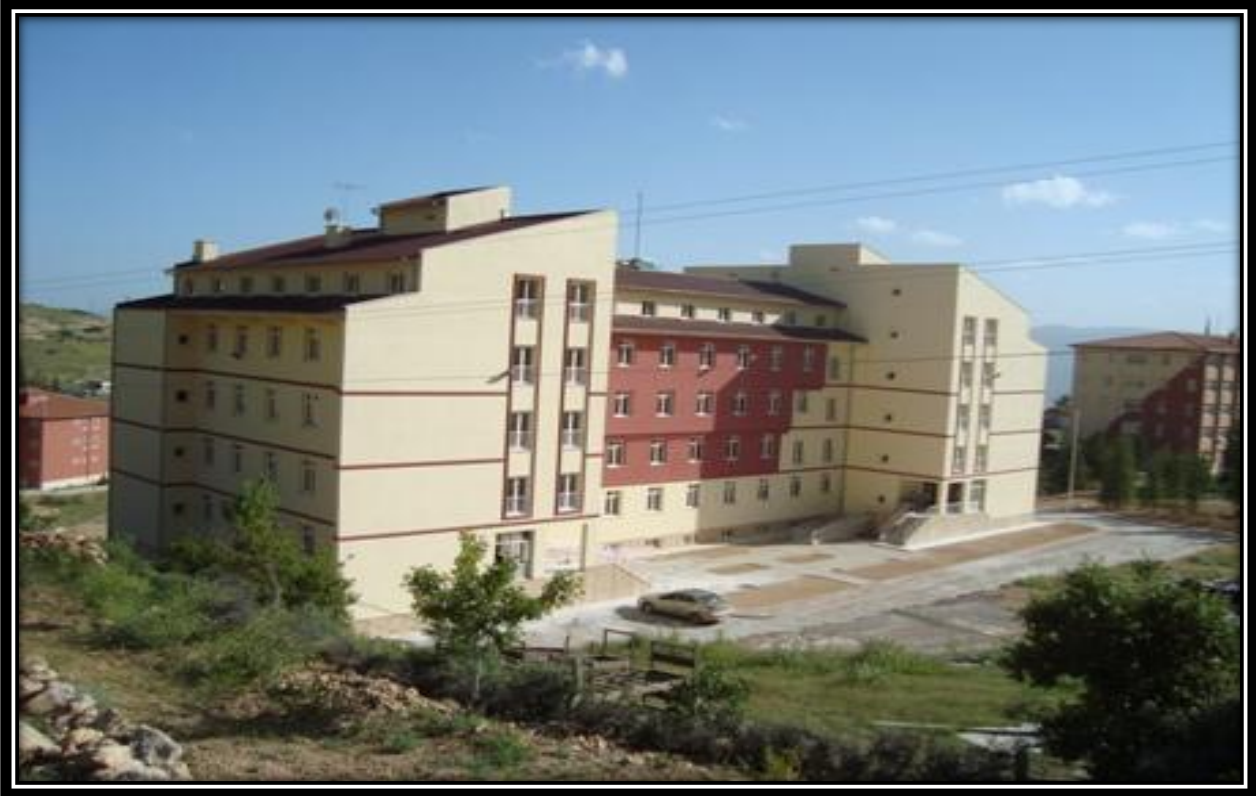
Ermenek 300 Yataklı Yurt Binası İnşaatı Görünümü
