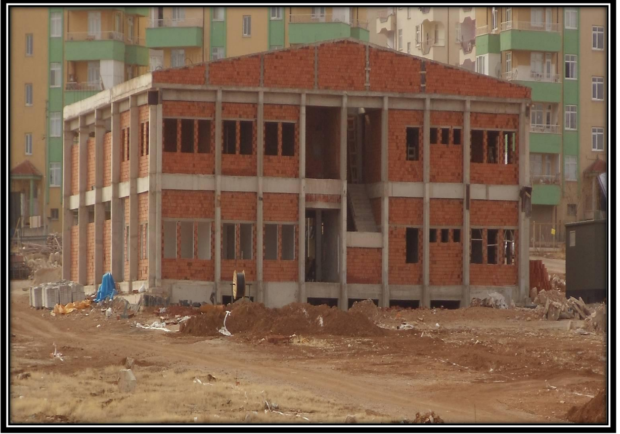
Isı Merkezi Galeri ve Otomasyon Sistemi Binası
