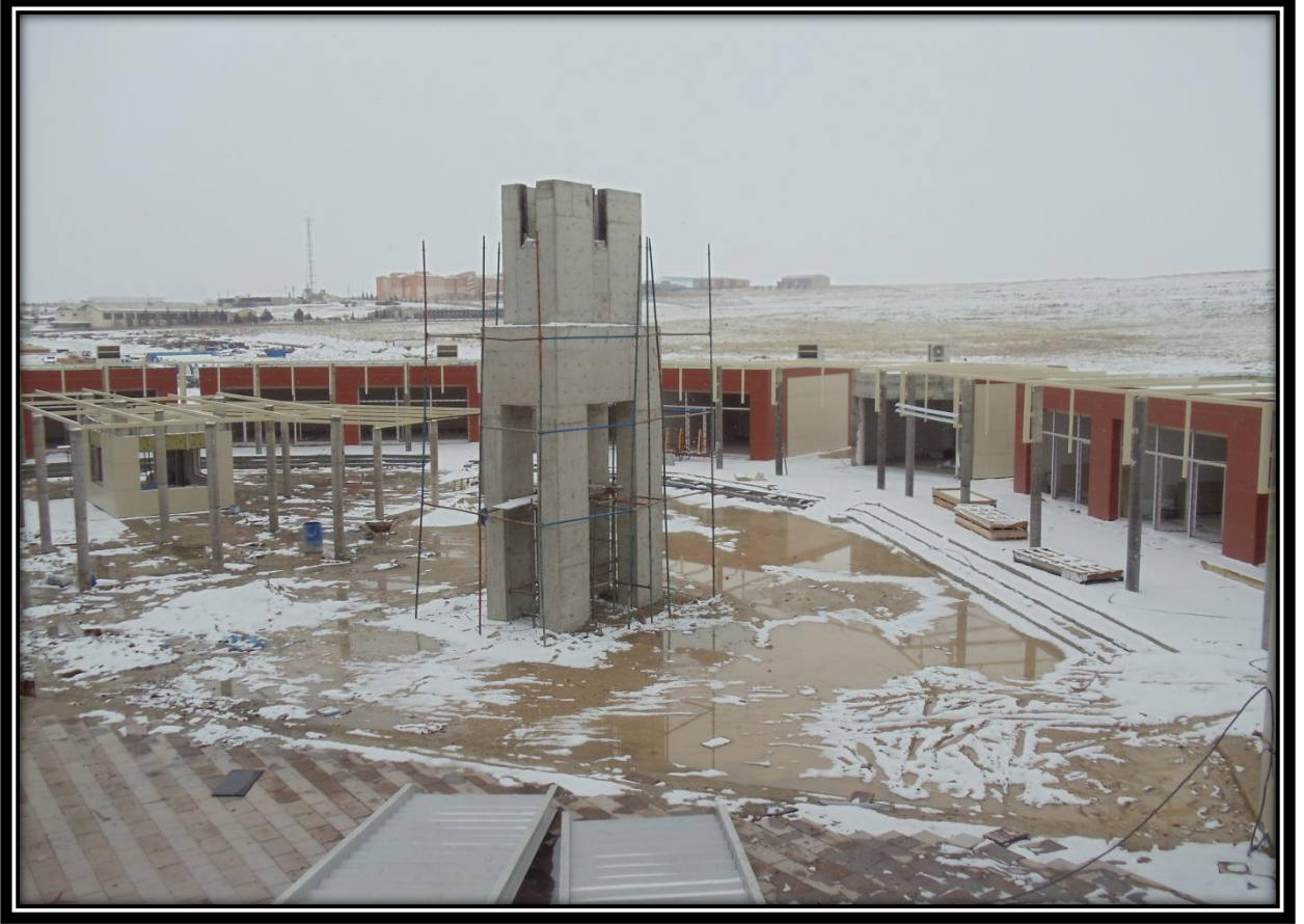
Yemekhane, Kafeterya ve Çarşı İnşaatından Görünüm
