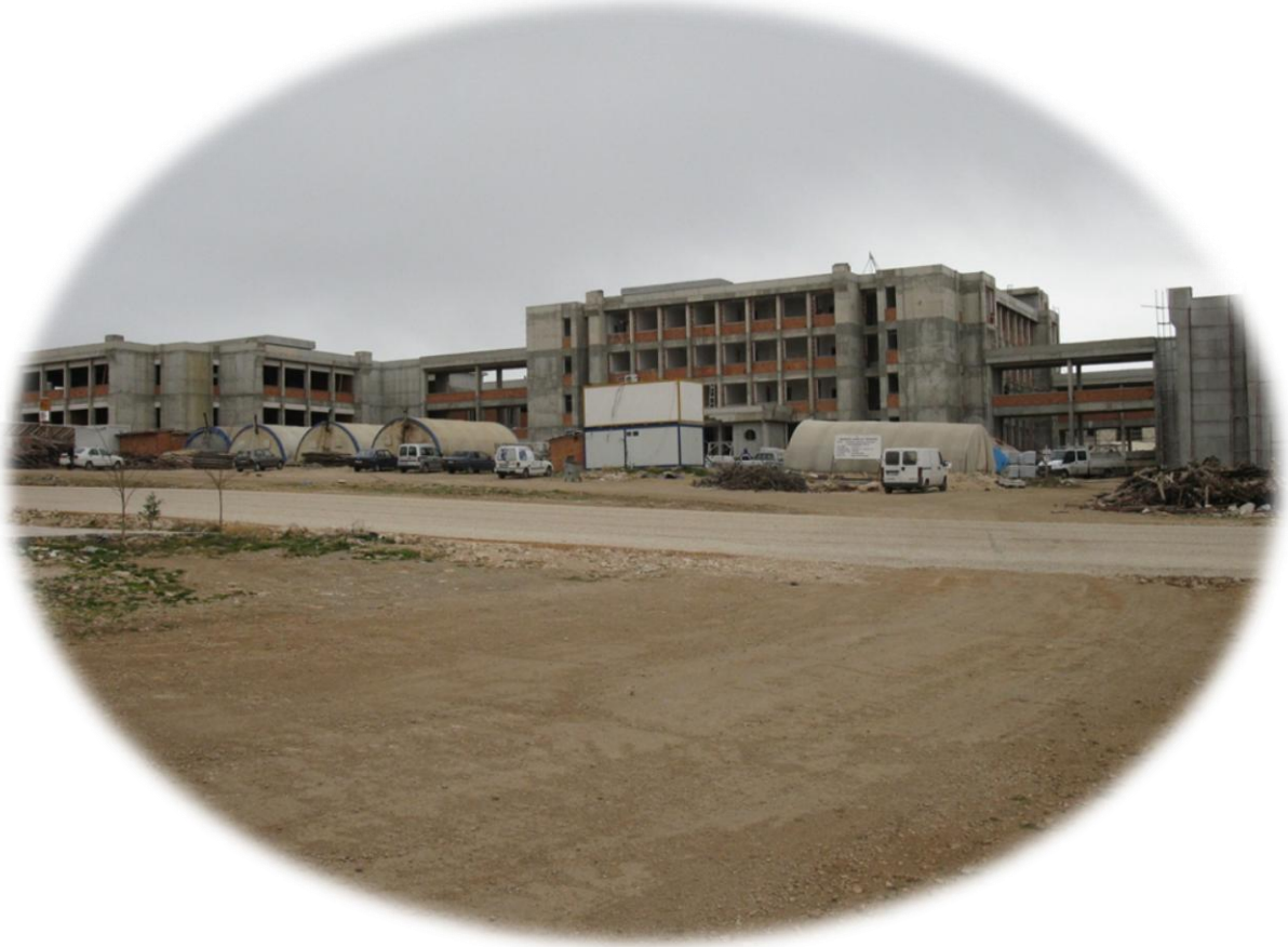
Meslek Yüksekokulu Bina İnşaatı Görünümü
