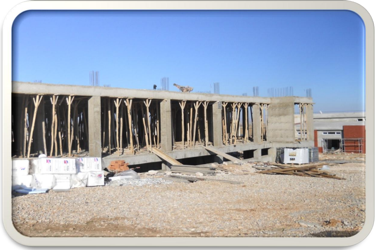
Merkezi Araştırma Laboratuvarı İnşaatı Görünümü
