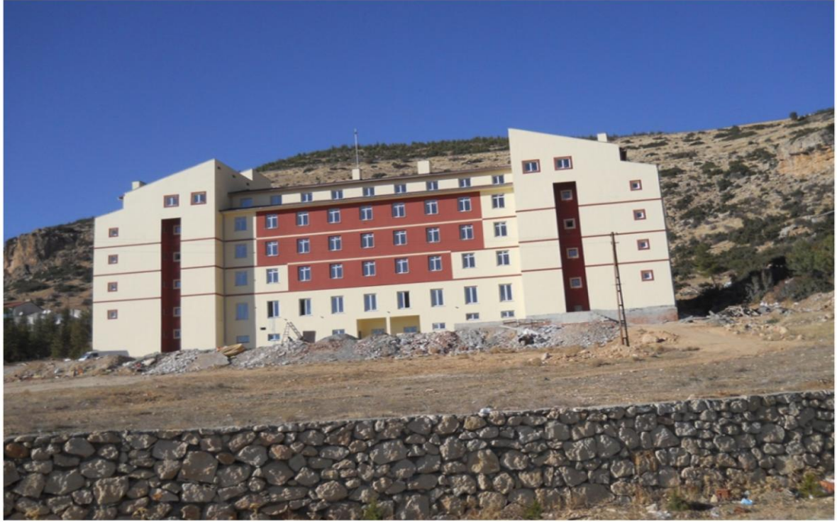
Ermenek 300 Yataklı Yurt Binası İnşaatı Görünümü
