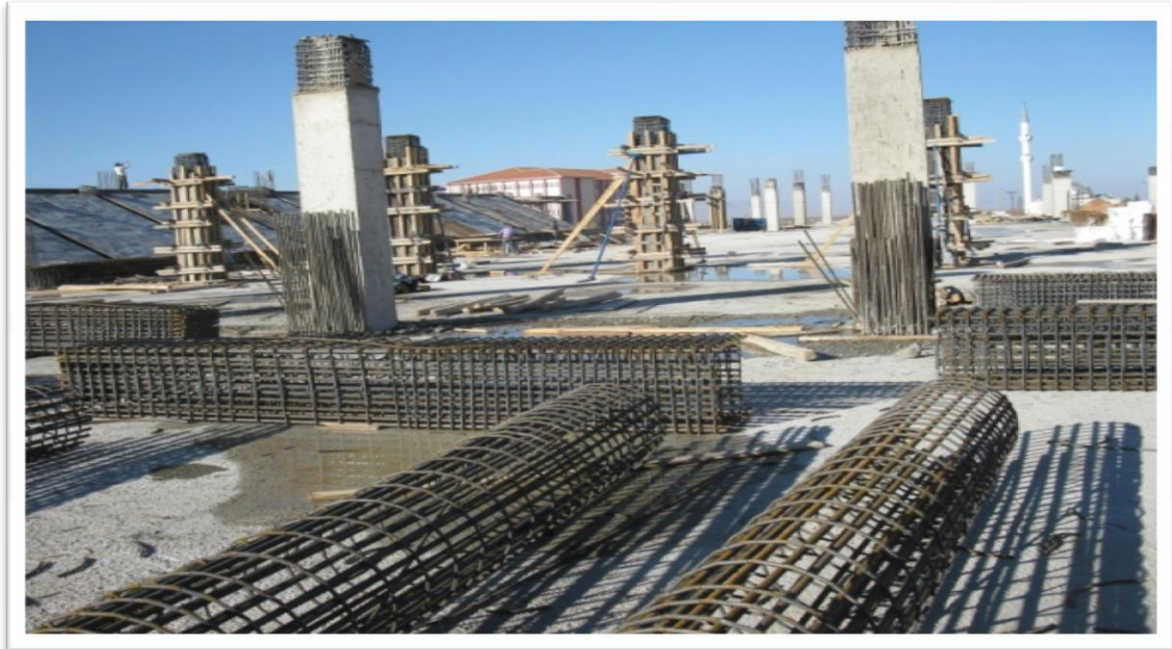
1500 Kişilik Kapalı Spor Salonu İnşaatından Görünüm
