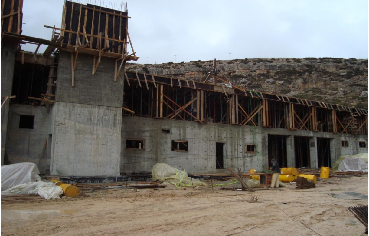
Ermenek 300 Yataklı Yurt Binası İnşaatı Görünümü
