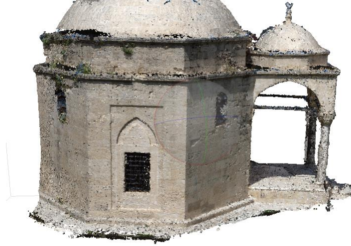
Şekil 8. Türbeye ait yoğun nokta bulutu
