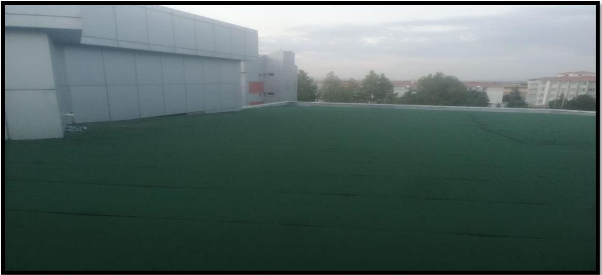
İktisat Fakültesi Çatı Yalıtım İşi
