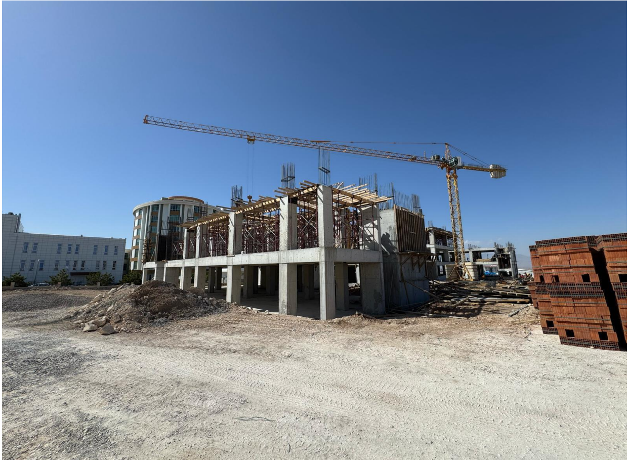
Resim 17: Tıp Fakültesi Morfoloji Binası Yapım Aşaması
