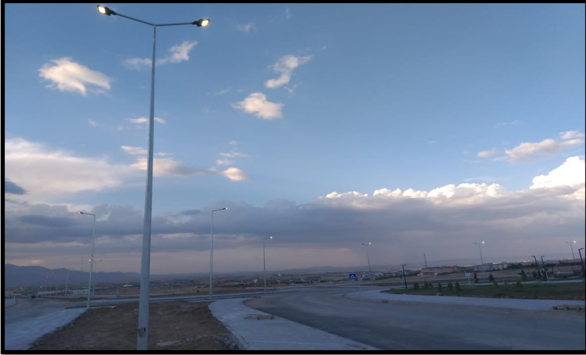
Resim 11: Kmü Güney Giriş Kapısı, Kaldırım, Refüj ve Yol Aydınlatma Yapım İşi
