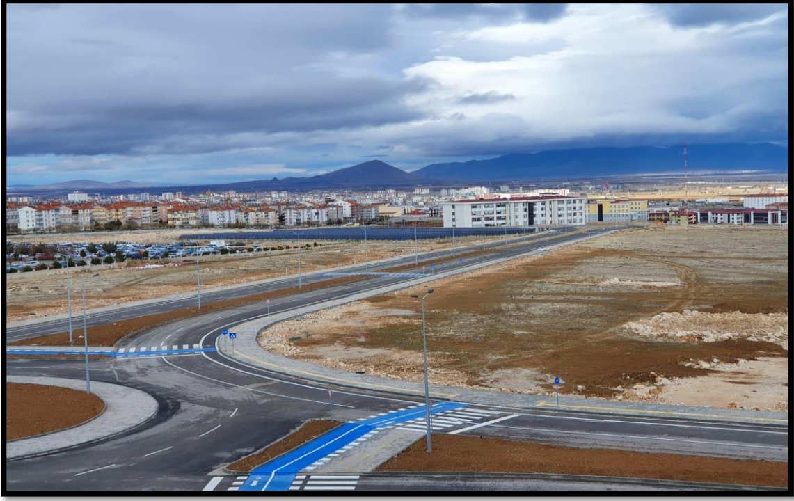
Resim 10: Kmü Güney Giriş Kapısı, Kaldırım, Refüj ve Yol Aydınlatma Yapım İşi
