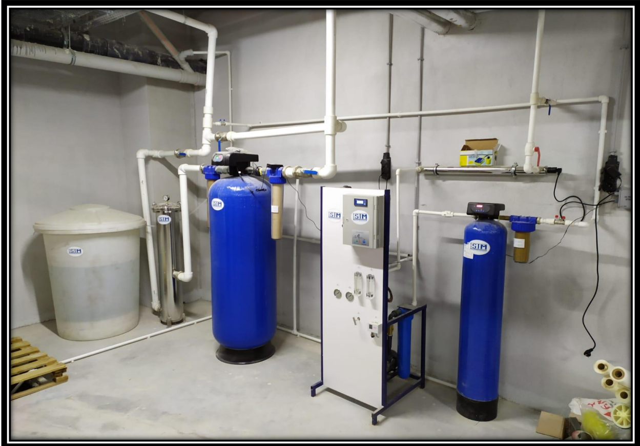
Resim 24: Ters Ozmos Sistemi (Bina Su Arıtma Sistemi)
