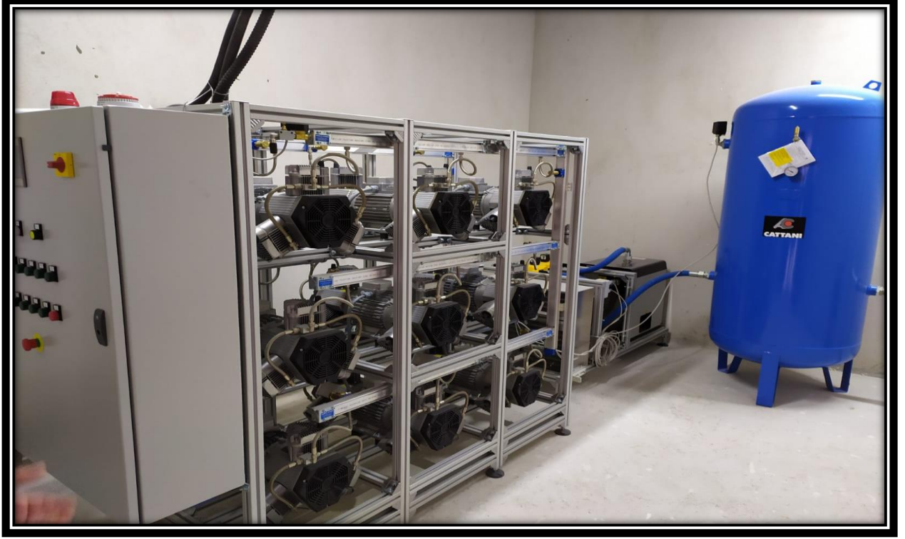
Resim 1: Merkezi Kompresör Sistemi
