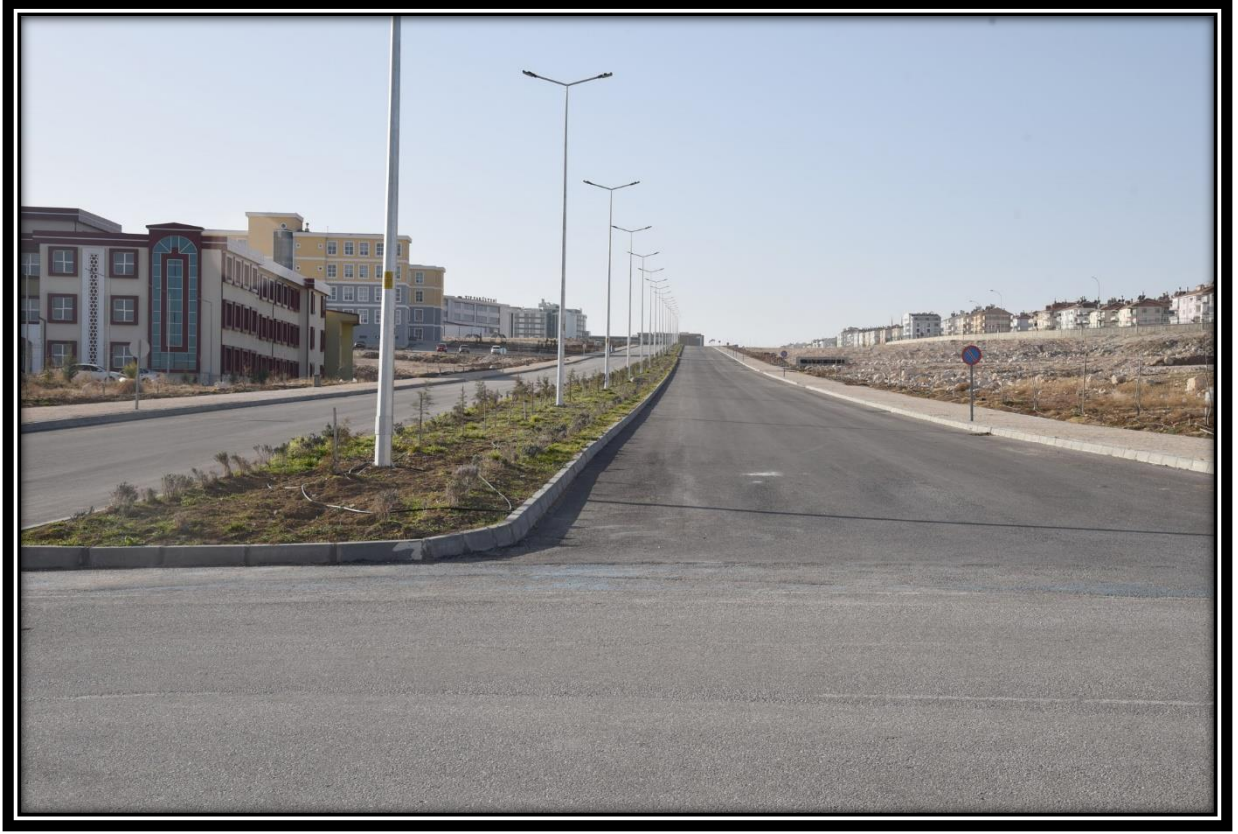
Resim 26: İkinci Etap Yol Yapım İşi
