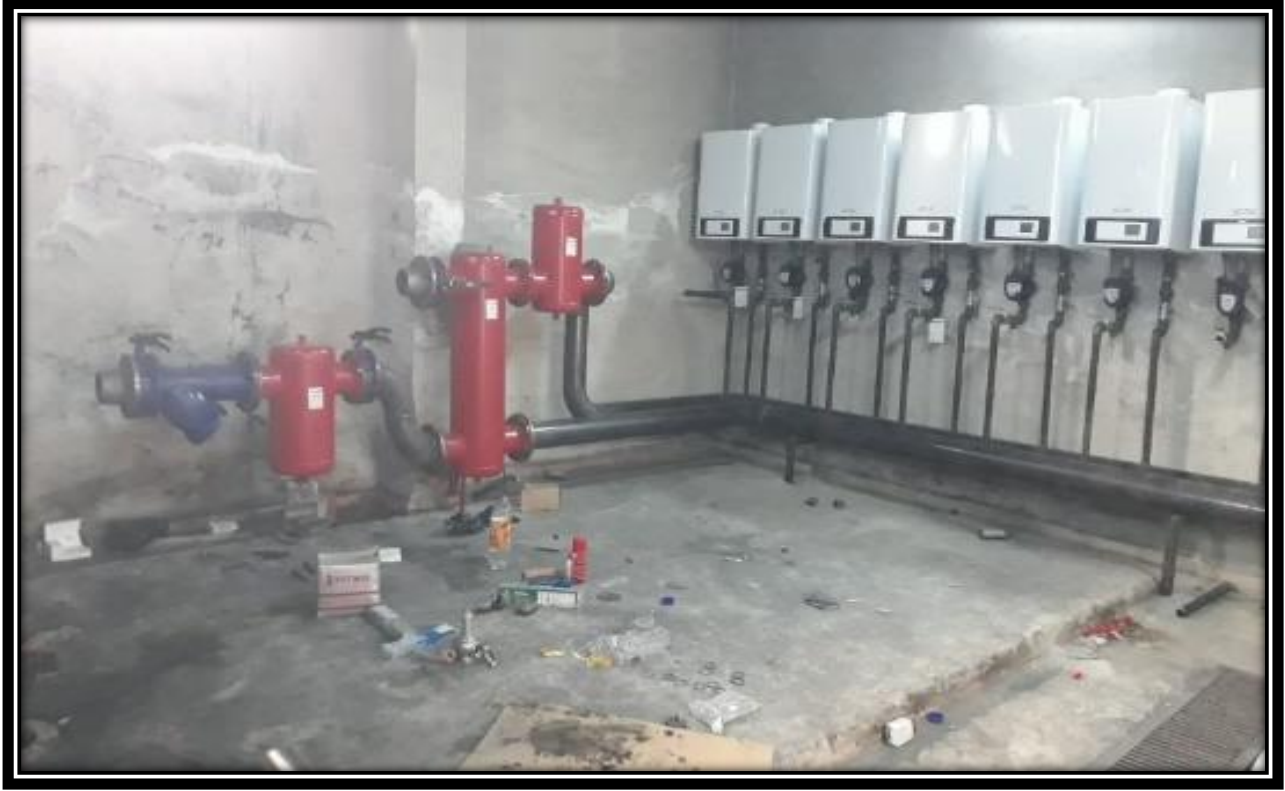
Resim 28: Doğalgaz Dönüşümü Yapım İşi Görselleri
