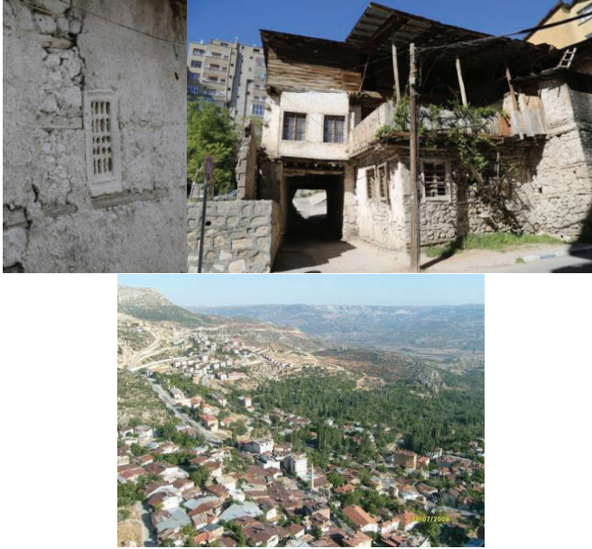
Şekil 15. Ahşap hatıllı yığma taş duvar Şekil 16. Bina aldı pasaj uygulaması, arka planda yeni binaların geleneksel doku ile uyumsuzluğu görülmektedir. (ermenek.bel.tr/) Şekil 17. Yeni konut ihtiyacı ile yükselmeye başlayan Ermenek (ermenekilcesi.blogspot.com/2009/)
