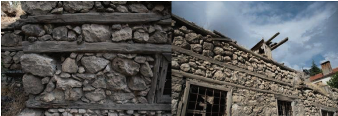
Şekil 2, 3. Ermenek Geleneksel Evlerinde Yöresel Malzeme kullanımı (Demirarslan, S.M., 2018 Özel Arşivi)
