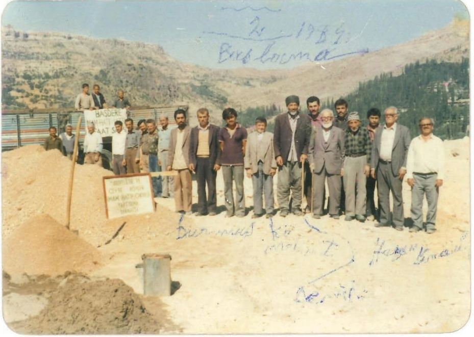
Sarıveliler'de okul inşaatı devam ederken
